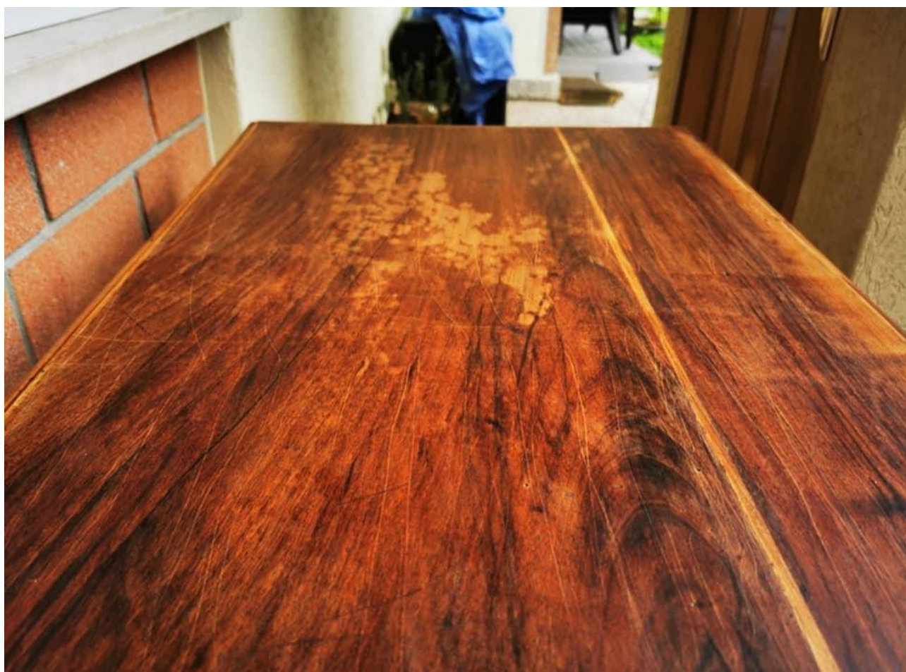
Le condizioni del piano di coperta
